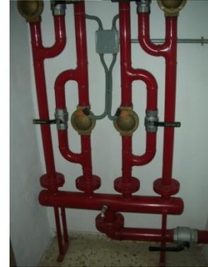
Los sistemas de rociadores automáticos disponen de electroválvulas que a través del sistema de detección de incendios ponen en carga las tuberías en caso de incendio. Manualmente se puede hacer girando la llave de paso que lleva incorporada.
